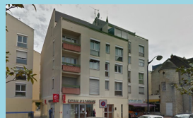
Résidence ALBERT DUGUÉ 97 logements - Creil
