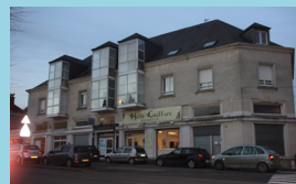
Résidence LE SARRAZIN 46 logements - Noyon
