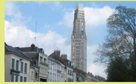
Tour PERRET 39 logements - Amiens
