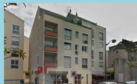
Résidence ALBERT DUGUÉ 75 logements - Creil
