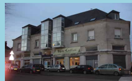
Résidence LE SARRAZIN 46 logements - Noyon
