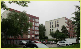
Résidence QUÉBEC 180 logements - Amiens
